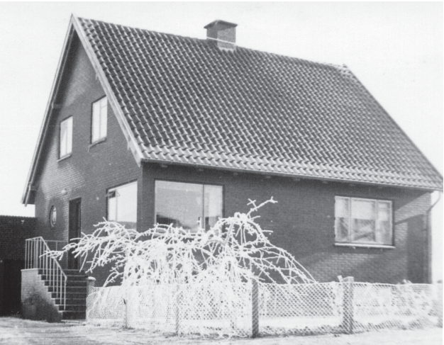
Læge Overbech Petersens hus på Sdr. Bygade 3 for tilbygningen i 1954.
