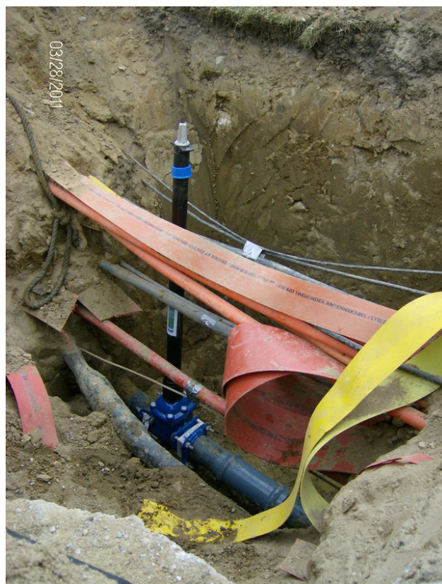
Besværligt gravearbejde for entreprenøren i 2012.
